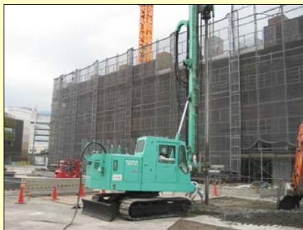
施工状況 (構造物に近接して施工)
