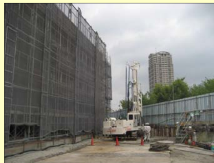
施工状況 (狭小部での施工状況)
