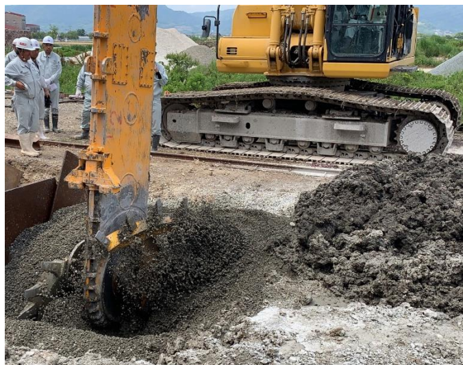
透水性地盤改良体造成の様子
